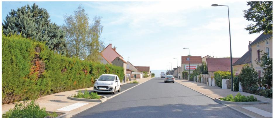
Champ Roubeau | Entamés le 19 juin 2017, les travaux de Champ Roubeau ont consisté en la dissimulation des réseaux aériens, le renforcement de l'éclairage public par la pose d'un nouvel éclairage Led moins énergivore et la rénovation de la chaussée, l'agrandissement des accotements et des trottoirs, la création de places de stationnement, la plantation d'arbres et de bandes végétalisées et aussi l'aménagement de passages piétons sécurisés.
